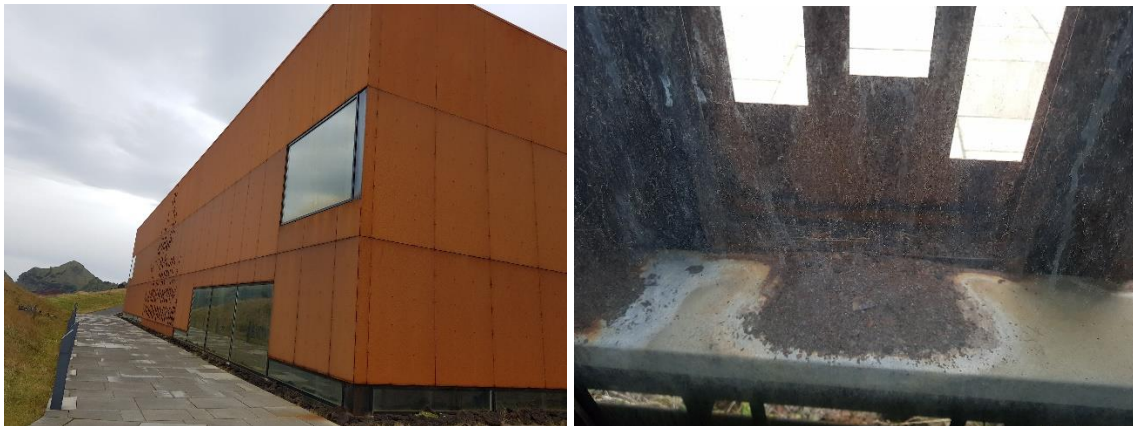
MYND 11 Eldheimar í Vestmannaeyjum. Til hægri sést hvernig ryðhúðin flagnar af innra borði klæðningarinnar.
